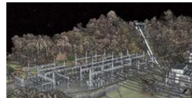
ドローンで撮影したデータから三次元モデル化した例：糖平発電所
